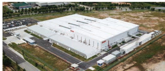
コイト・マレーシア工場全景
